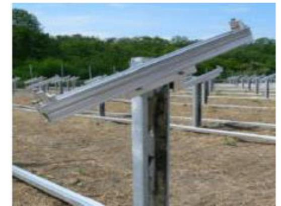
Illustration de la structure supportant les modules photovoltaïques
